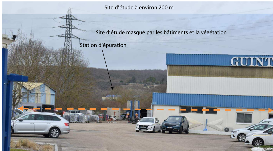
Cliché 12 : Depuis l'accès au parking d'une entreprise de la zone industrielle, en bordure de la D0615 - Les vues vers le site sont masquées par la végétation, le bâti, les dépôts divers - Sensibilité nulle
