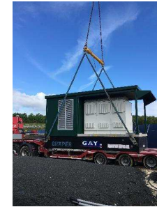
Figure 122 : Livraison d'un poste électrique
