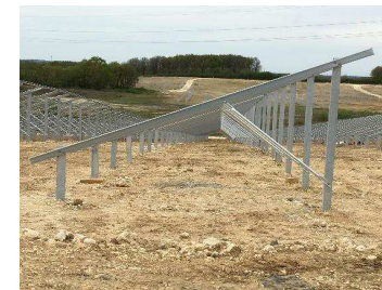
Figure 119 : Exemple d'une structure porteuse complète avant mise en place des panneaux
