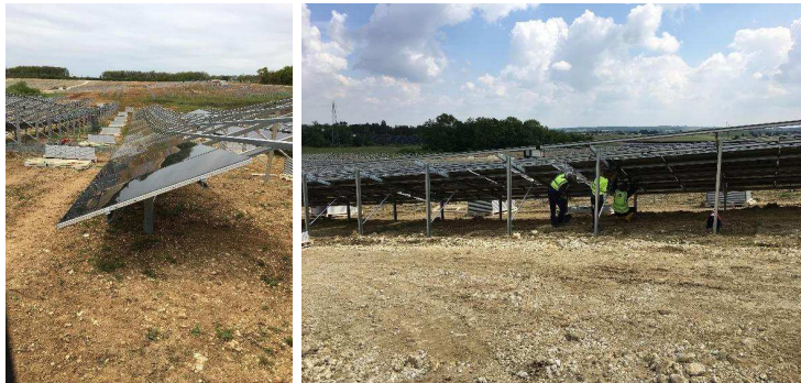
Figure 121 : Exemples de mise en place de panneaux sur les chantiers URBASOLAR
