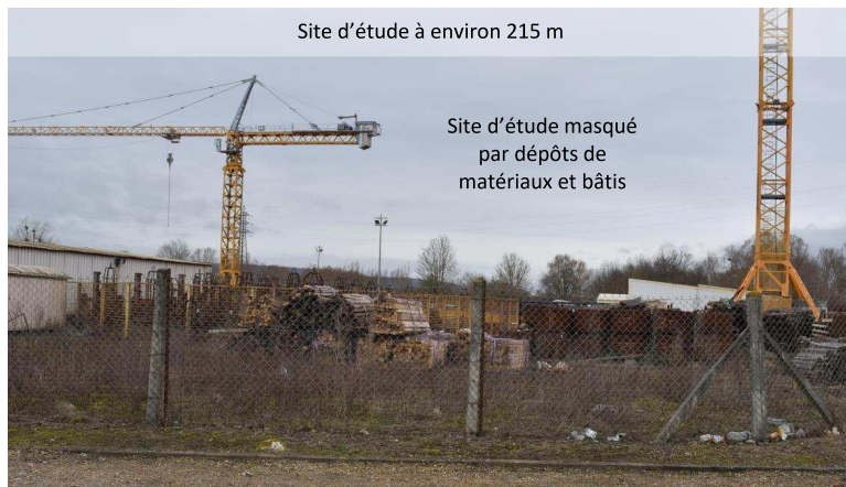
Cliché 6 : Rue de l'hôtel des Prés - Malgré l'orientation des façades d'habitation vers le nord-ouest (vers le site d'étude) les activités de la zone industrielle (dépôts de matériaux métallurgiques) ferment les vues – Sensibilité nulle
