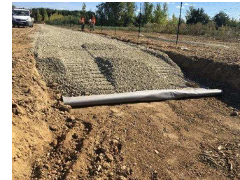
Figure 116 : Exemple de réalisation de voie d'accès interne
