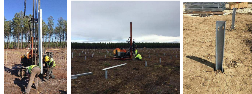
Figure 118 : Exemple de pieux battus et de leur mise en place sur les chantiers URBASOLAR
