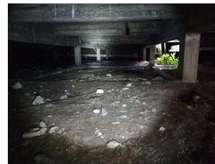
Figure 67 : Dalle de béton, vue du dessous
