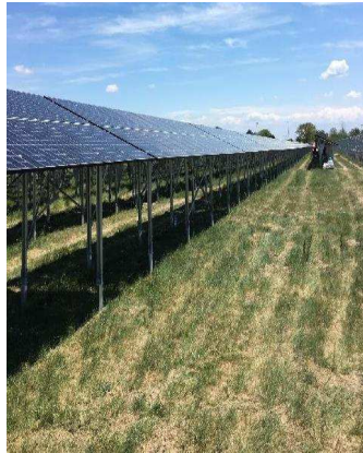
Figure 120 : Exemple de surélévation des panneaux sur la centrale au sol photovoltaïque de Salins-de-Giraud (13) avec un risque de submersion marine de 2 à 3 m / URBASOLAR
